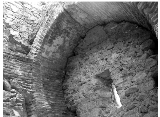
Fig. 5. Interior del piso inferior de la torre con vistas de la bóveda tumida (Imagen: D.G.P.)
