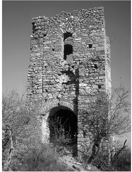
Fig. 3. Vista de la fachada oeste de la torre (Imagen: D.G.P.)
