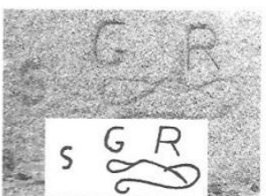
un sillar situado en uno de los respaldos, junto a la cabecera, en donde se vislumbra una S, junto con una GR y un dibujo lineal el cual pueda ser una rúbrica, es decir, que serían las iniciales del maestro de cantería que
